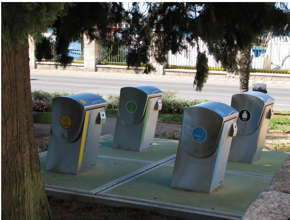
Slika 12. Podzemni spremnici postavljeni u užem centru grada Pule, Izvor: Pula Herculanea d.o.o.
