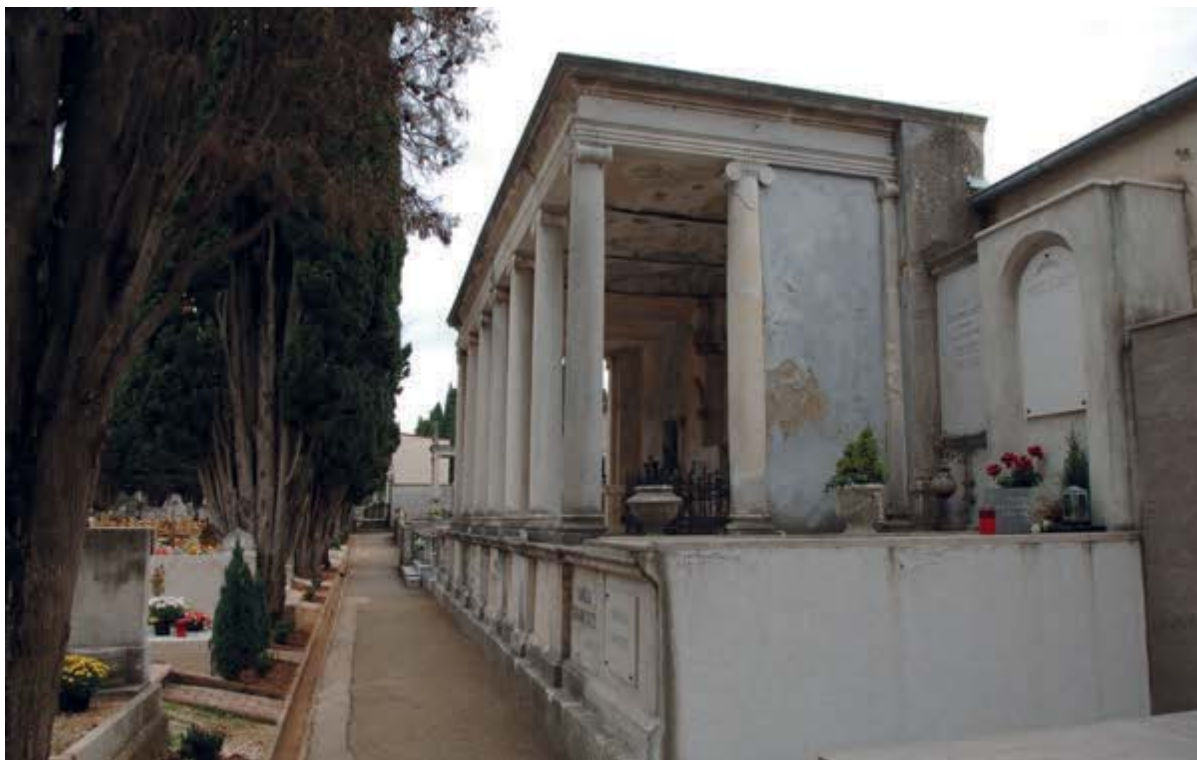
Fig. 98. Dettaglio del viale laterale destro del campo A.
