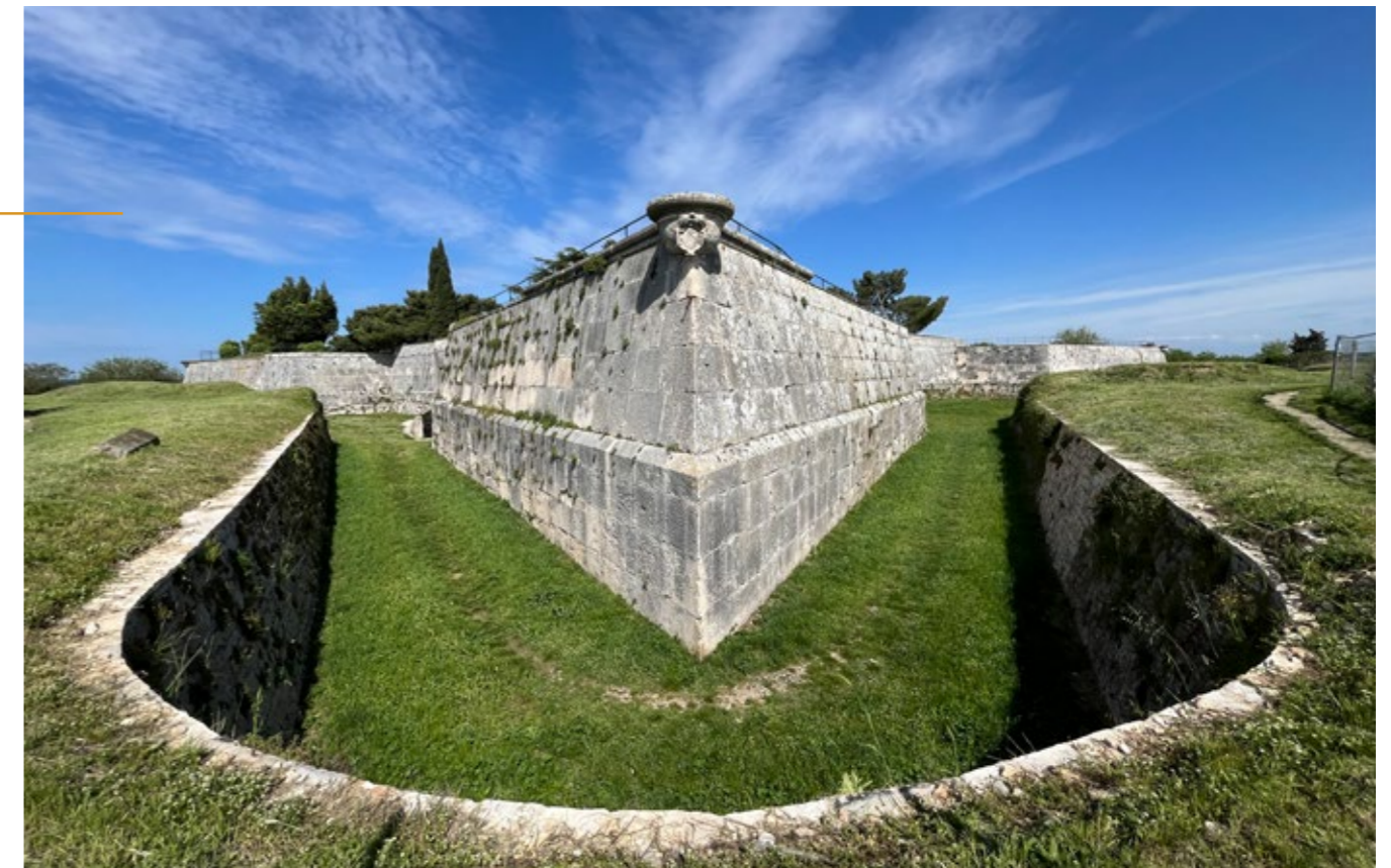
Ugaoni bastioni tvrđave Kaštel, Izvor: Urbanex d.o.o., 2024.
