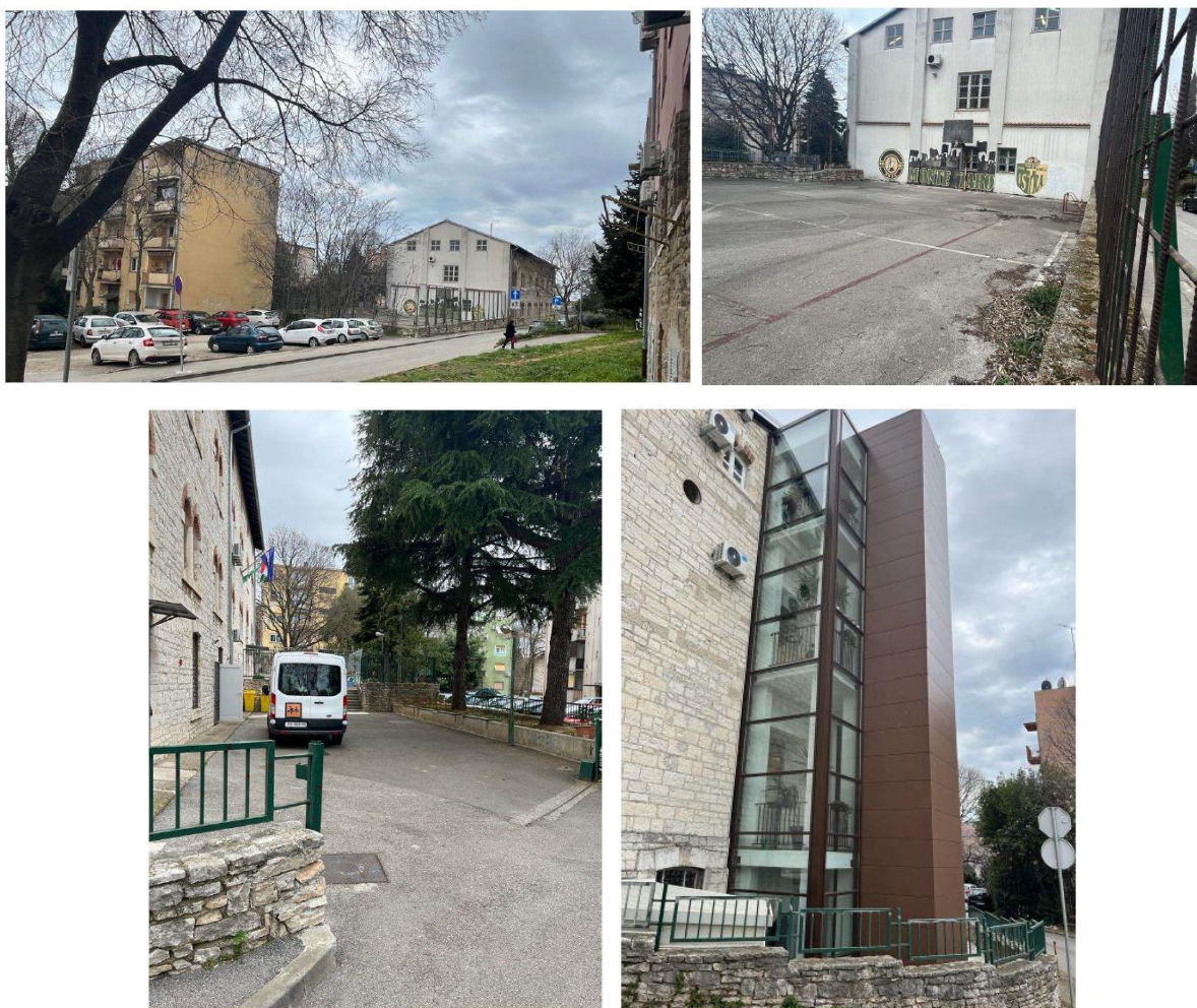
Fotodokumentacija trenutnog stanja Škole za odgoj i obrazovanje - Pula (izvor: elaborat "Provjera prostorno-planske dokumentacije sa analizom mogućnosti rekonstrukcije Škole za odgoj i obrazovanje - Pula", Alter Lego Studio d.o.o.)
