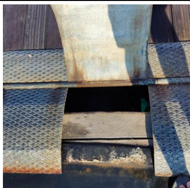
Slika 6: neadekvatni spoj
