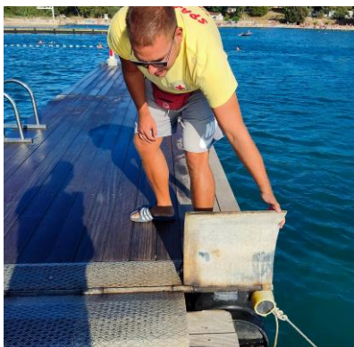
Slika 5: spoj pontona i betonskog mola
