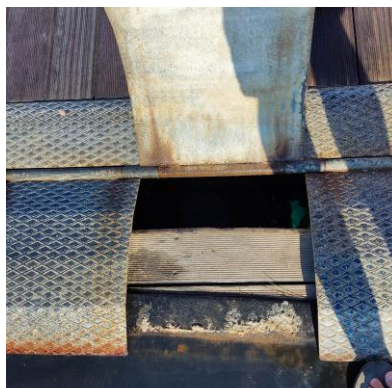
Slika 6: neadekvatni spoj
