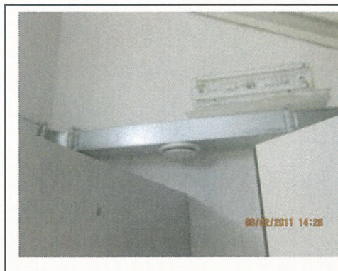
Ventilacija sanitarnih čvorova za gledatelje pod tribinama
