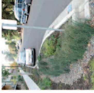
Drenažne (infiltracijske) zelene površine uz prometnice s eksteriornim prometom
