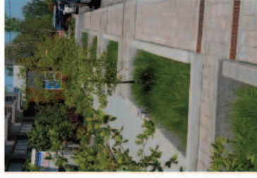
Drenažne (infiltracijske) zelene površine uz prometnice s eksteriornim prometom
