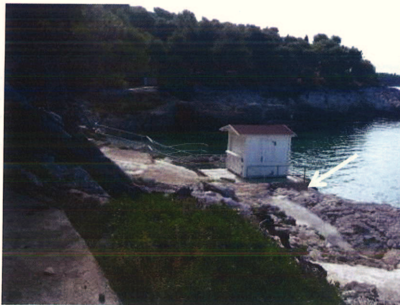
Slika 1. Pogled na havajsku plažu i crpnu stanicu (označeno strelicom)
