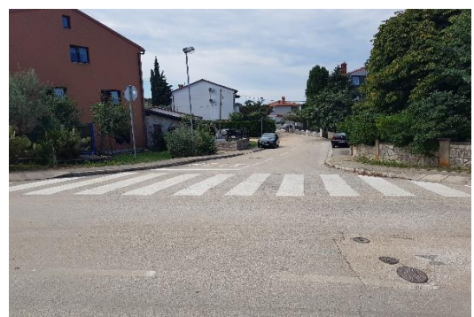
Pristupna prometnica kojoj je pripadak predmetna nekretnina
