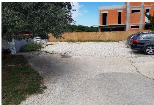
Predmetna nekretnina, pripadak prometnice
