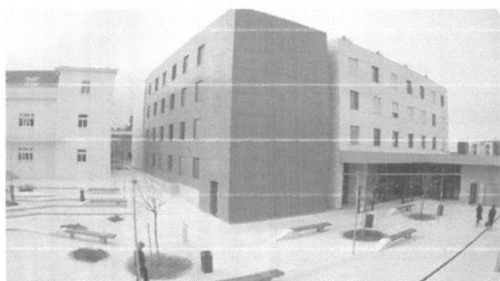
Pula: Gradilište Studentski dom
