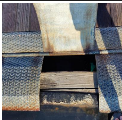
Slika 6: neadekvatni spoj
