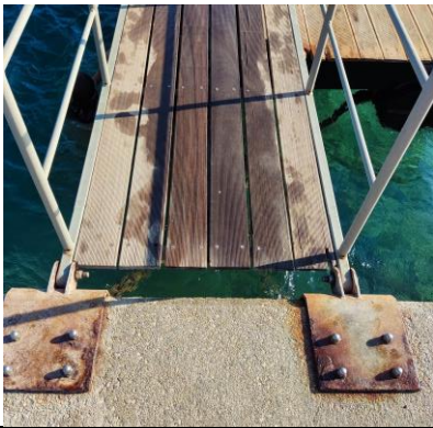
Slika 9: razmak između pontona i kopna
