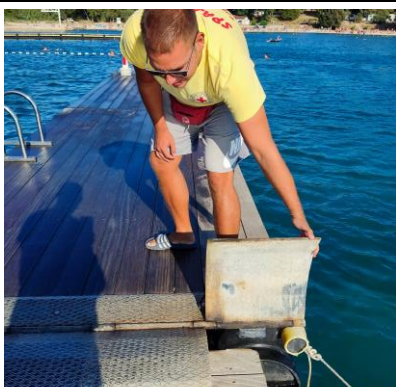
Slika 5: spoj pontona i betonskog mola
