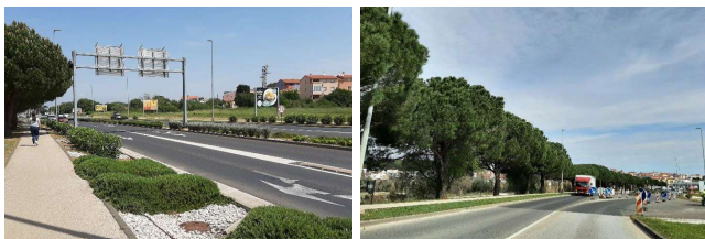
Slika 73 Pulska zaobilaznica (autorska fotografija)
